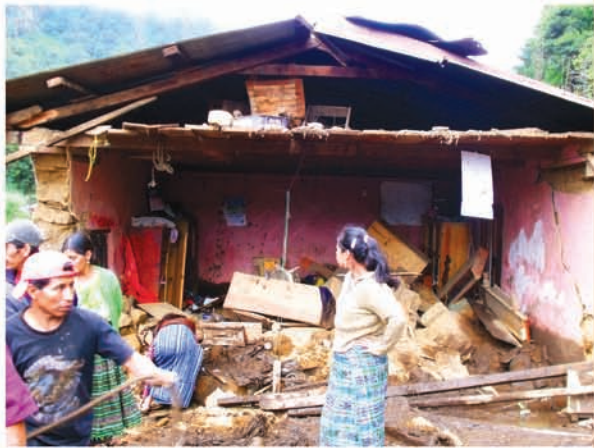
Casas destruidas por la depresión tropical Agatha.
